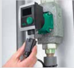
Hızlı elektrik bağlantısı sağlayan Wilo Connector
